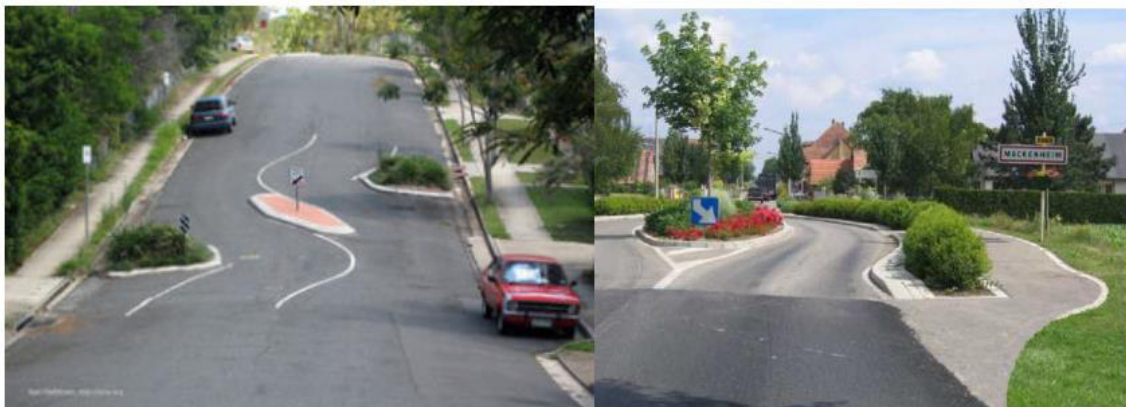
Figura 66 - Esempi di disassamento stradale.
