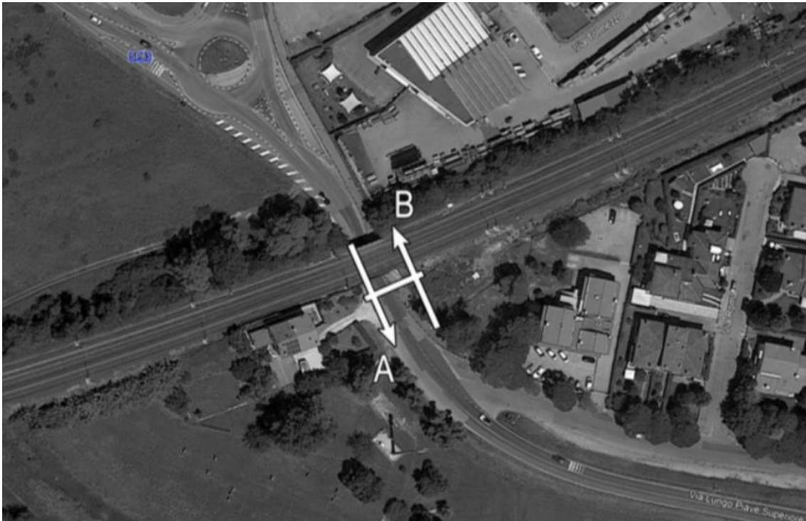
Figura 5 - Ubicazione della sezione R01 sotto il ponte della ferrovia in zona centro studi.
