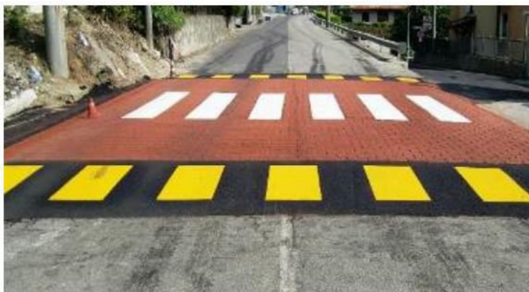
Figura 62 - Attraversamento pedonale rialzato.
